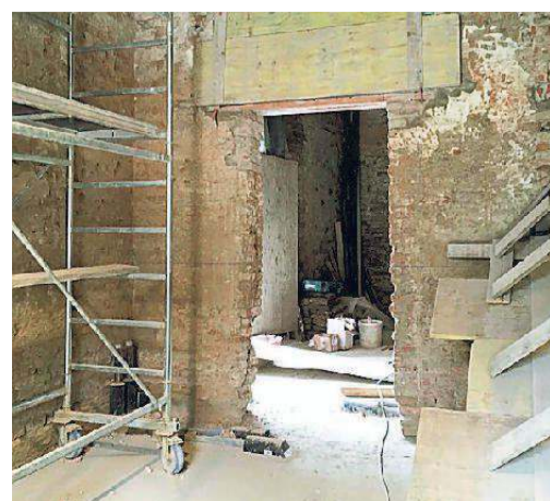
I lavori di restauro per realizzare la biblioteca ragazzi
