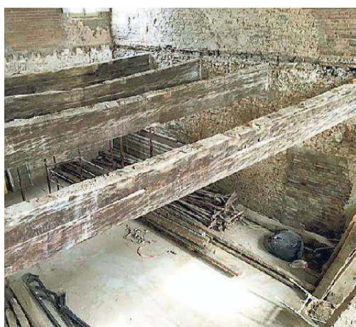
L'interno del cantiere di casa Niccolini
